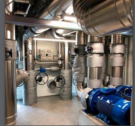
Die Anlage hat eine Kapazität von 2 x 10 MW und kann das Gebiet Hjermvej und Søndergård mit Wärme versorgen. In den Wärmetauscheranlagen wird das 85°C heiße Wasser in 67°C heißes Wasser umgewandelt, das an die Verbraucher verteilt werden kann. Die Hydrophoranlage sorgt dafür, dass der Druck im System konstant bleibt. Die Anlage liefert Wärme für 3.000 Haushalte.
