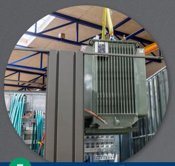
Die Trafostation kann als Plug & Play-Lösung geliefert werden. Hierbei wird die Station vor Ort an der Bodenplatte gehoben und auf ein Sandbett gesetzt. Anschließend wird die Station angeschlossen und ist danach betriebsbereit. Das Abladen wird entweder vom Kunden oder von Priess organisiert.
