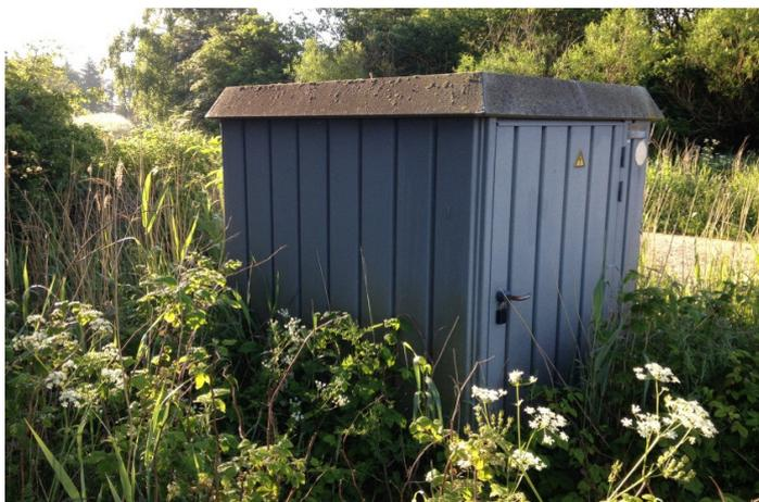
Beispiel einer Station mit großem, mechanischem Verschleiß des Anstrichs aufgrund von Bewuchs.
